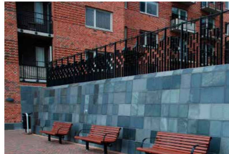
Beklädnadsmur, 30 mm plattor av Offerdalsskiffer. Sörhalls kajen, Göteborg.
