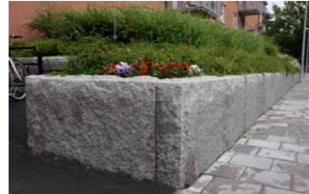
Låg blockstensmur i bostadsområde i Solna.
