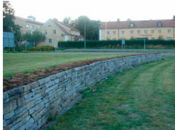
Kallmur av staplade kalkstensskivor, avtäckning med sedum. Rondell i Skövde.
